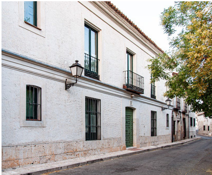
Rehabilitación en plaza de San Antón, antiguo edificio de Cáritas. Fotografía del autor.
