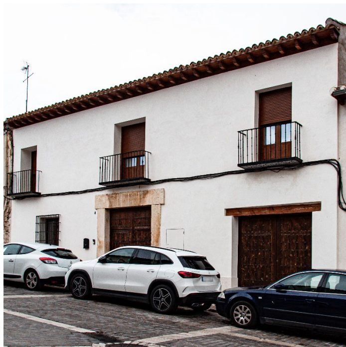
Reciente rehabilitación en calle de la Cueva. Fotografía del autor.
